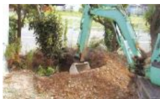
バックホーによる穴掘り
